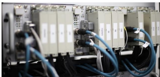
Obrázek 45. Panel EVC s nainstalovanými kabely
