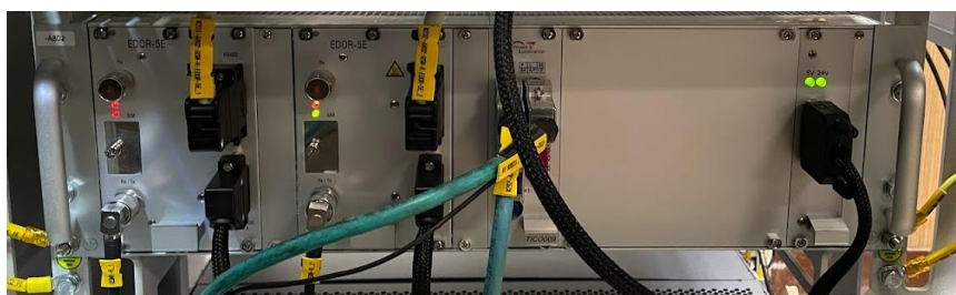
Obrázek 93. Panel GSM-R s nainstalovanými kabelem
