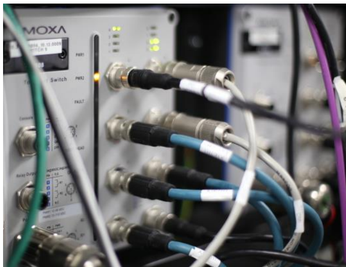
Obrázek 50. Přepínače TN5508A s nainstalovanými kabelemi
